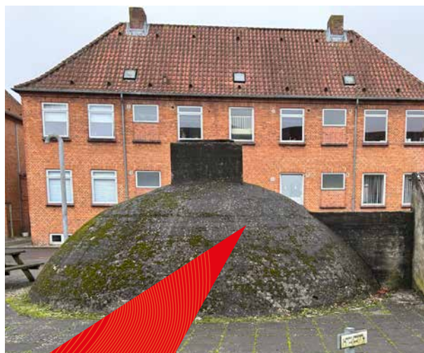
Aabenraa – sikringsrummet blev fritlagt for år tilbage
